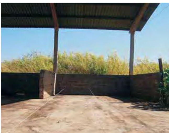
Fig. 2. Ferramentas necessárias e marcação do área para montagem da pilha de composto. Embrapa Hortaliças, 2008.
