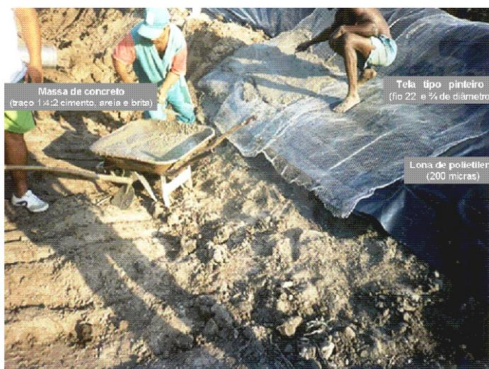
**Figura 4:** Detalhe da construção do vertedouro.
