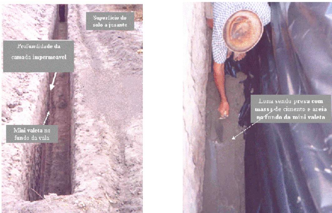
**Figuras 1 e 2:** Detalhes da instalação da lona.
