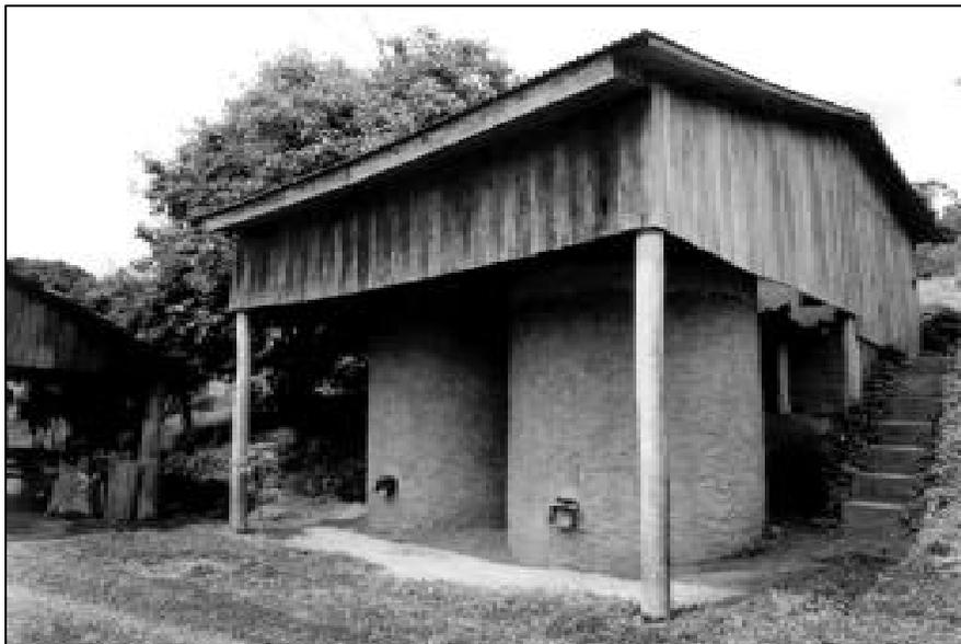
Figura 1 - Vista externa dos silos de alvenaria armada com capacidade estática de 150 sacos cada, na propriedade de Alcides e Clenio Basso, no município de Nova Bréscia, RS.
